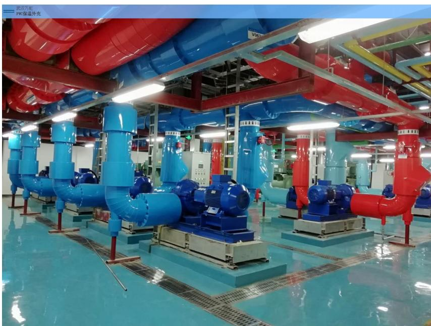
上海赛洛林工程材料科技有限公司生产的专业PVC复合保温外壳系列直管经过特殊工艺加工，根据（管道+保温）直径的大小预制成型各种管径的直管，在安装过程中，快捷，方便，美观。适应于各种管道及设备的保温、保冷系列的外层保护。可替代各种传统金属外保护材料。适用于：一般（管道+保温）直径小于200mm,用预制成型的直管安装，更方便，快捷[PVC保温外壳可选颜色：白色、灰色、黑色、红色、橙色、黄色、蓝黑色、深蓝色、浅蓝色、深绿色、浅绿色、紫色[PVC保温外壳应用注意事项：除白色外的其它颜色，不宜应用于户外及阳光直晒的场合。
